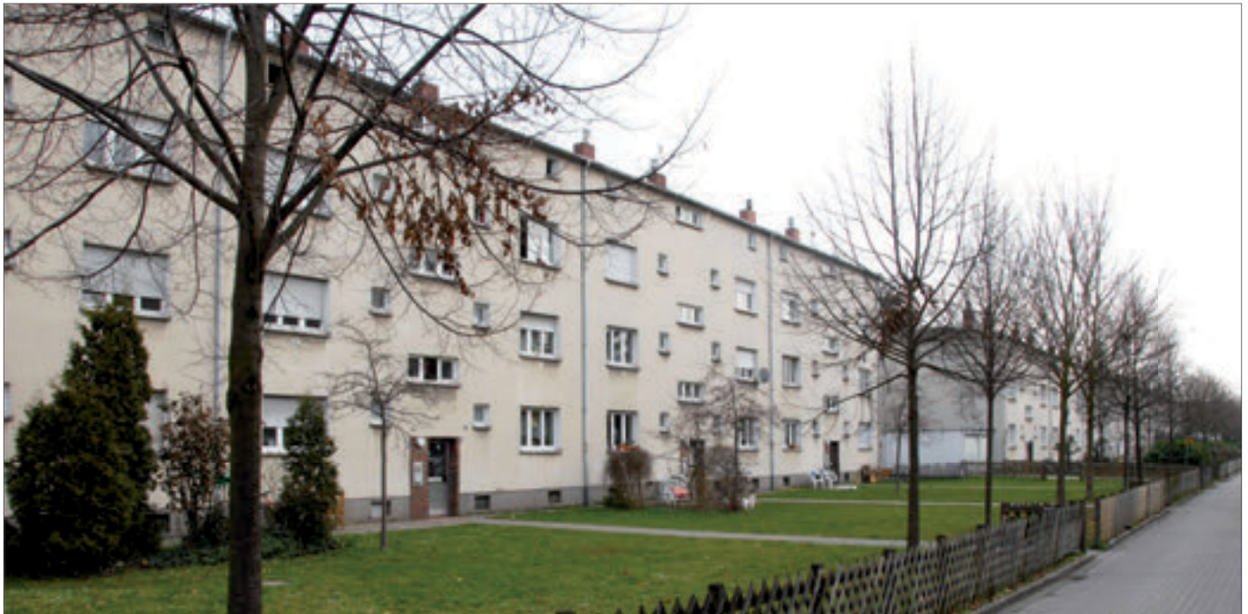
Bäckerwegsiedlung, Herxheimer Straße 1 – 25, Foto um 2010
