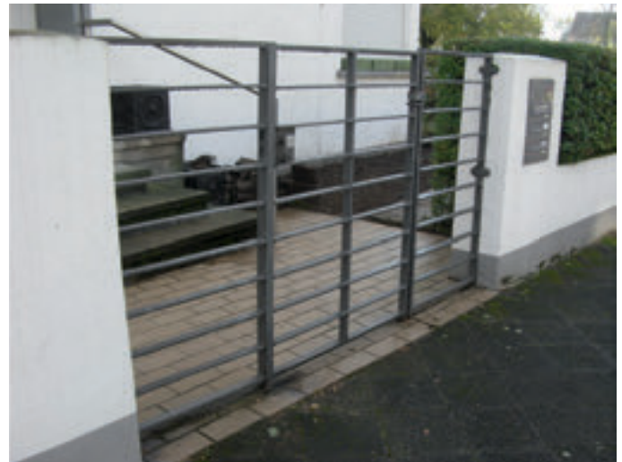
Mannheim, Mietshaus Thum/Wohnhaus Gerwig, Einfriedung
