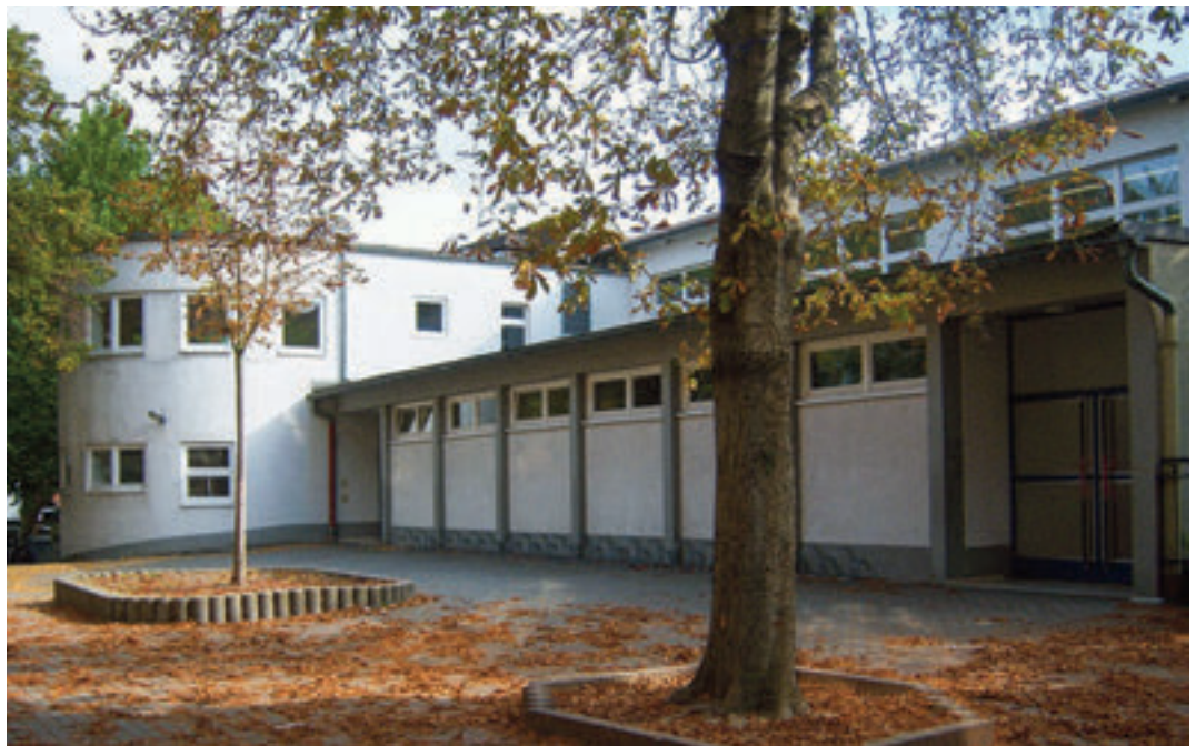
Mannheim, evangelisches Gemeindehaus Neckarau, Fassade, Foto 2009
