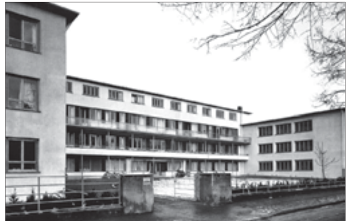
Jüdisches Altersheim, Straßenfassade nach Aufstockung des Baukörpers und Anbau von Balkonen, Foto um 1960
