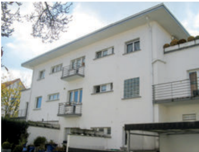
Mannheim, Mietshaus Thum/Wohnhaus Gerwig, Rückfassade, Foto 2012
