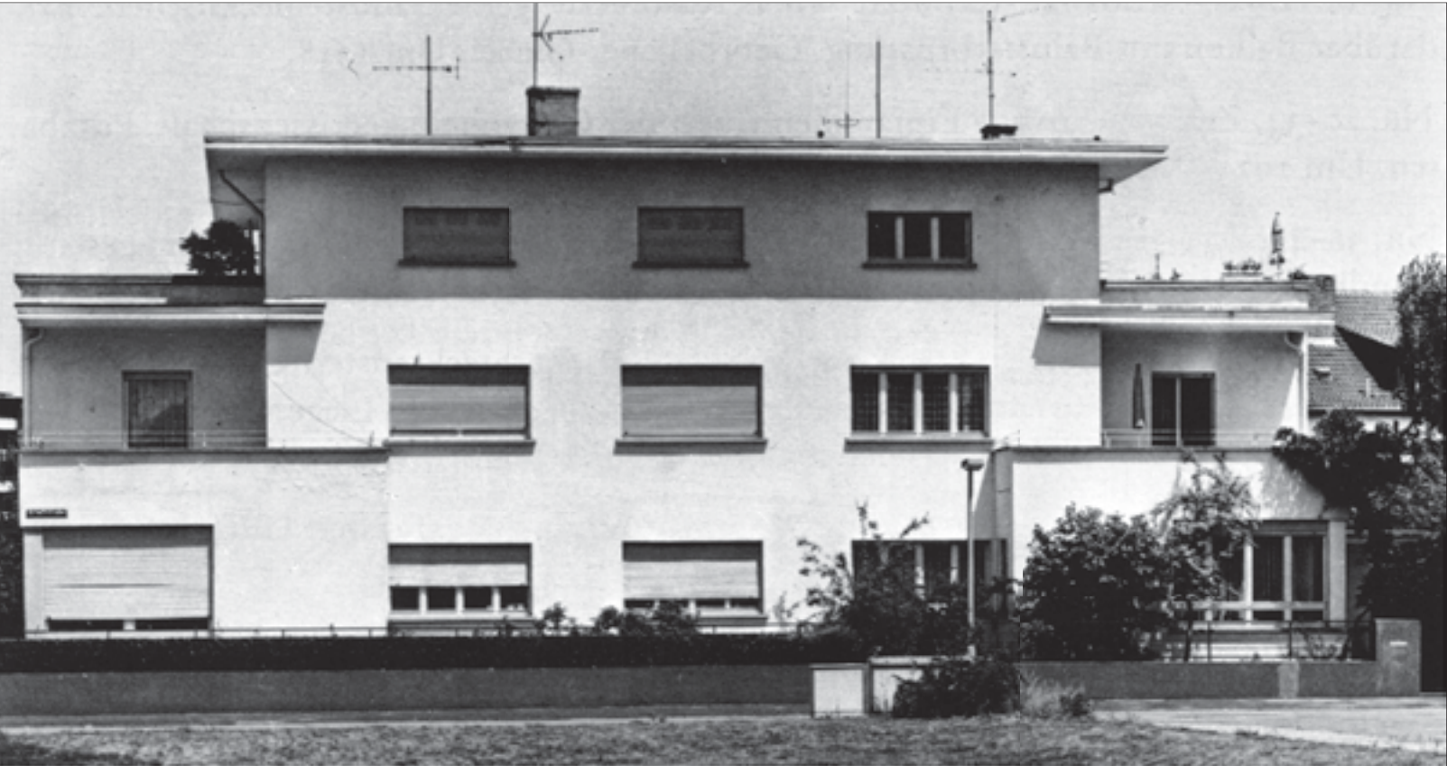
Mannheim, Mietshaus Thum/Wohnhaus Gerwig, Straßenfassade, Foto um 1980
